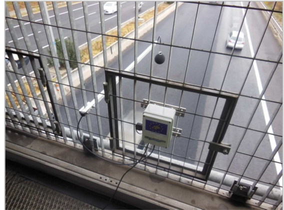
Figura 4 – Installazione di uno dei dispositivi effettuata sul GRA.
